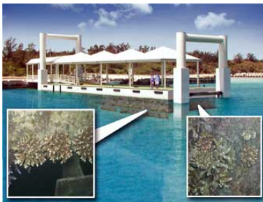
微弱電流が通電されている部分に稚サンゴが多数活着
