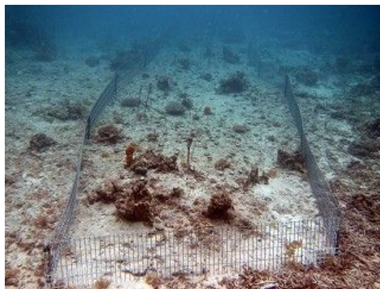
図Ⅱ. 10. 17 漂礫対策用柵設置ユニット
