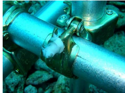
図Ⅱ.5.8 シリコンによるクランプねじの生物付着防止
