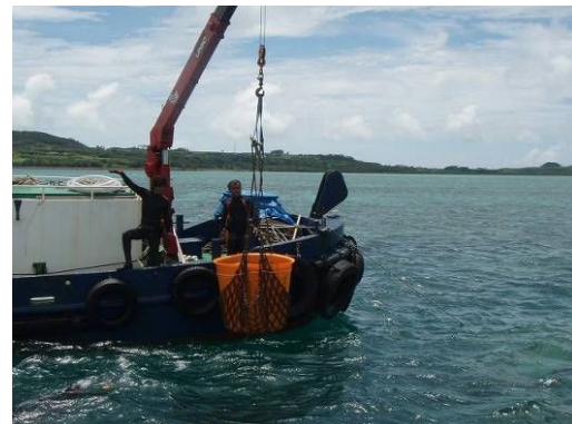
海水タンクの吊り上げ状況
