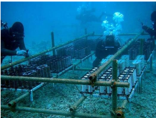
図Ⅱ.5.9 着床具架台設置
