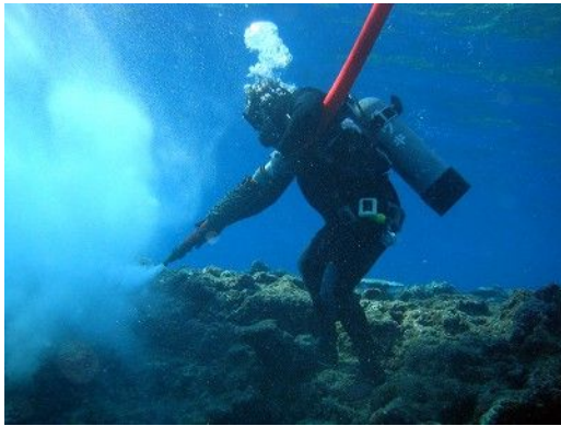
図Ⅱ.10.5 ジェットポンプによる瓦礫の除去
