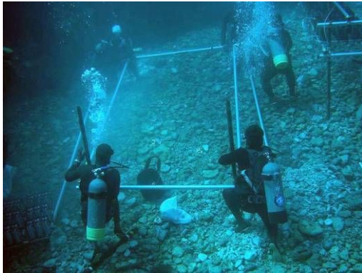
図Ⅱ.5.7 足場パイプ枠組立
